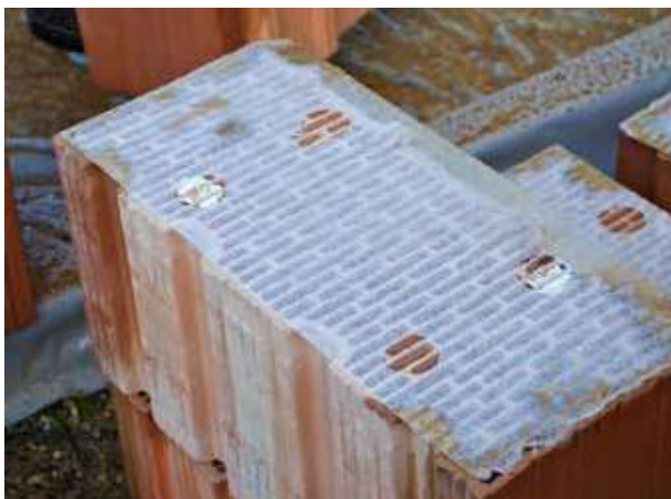
» Dismantled tile with fleece and adhesive » Demontierter Ziegel mit Vlies und Kleber
