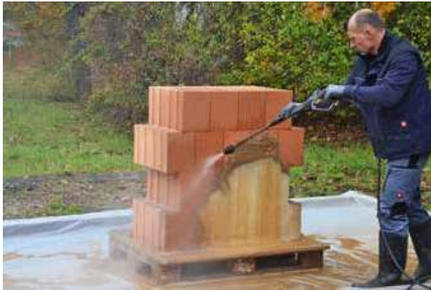
» Hosing down the clay plaster with water » Abspritzen des Lehmputzes mit Wasser
