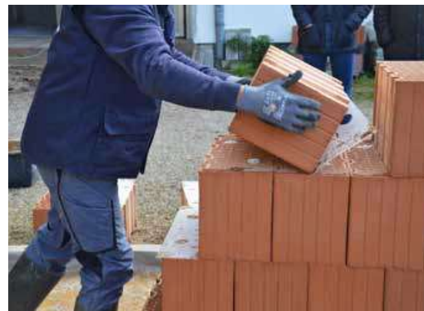
» Simple dismantling of a brick wall » Einfache Demontage der Ziegelwand
