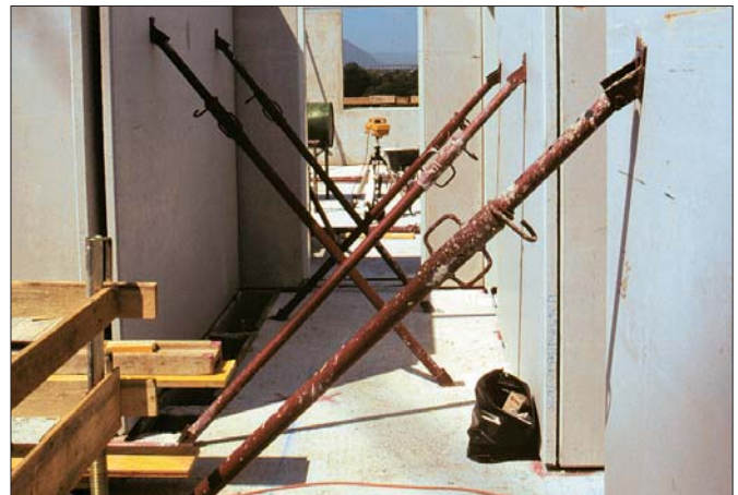
Bild 16: Sicherung der Wandelemente mit Schrägstützen
