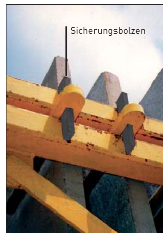
Bild 6: Sicherungsbolzen für benötigtes Element entfernen
