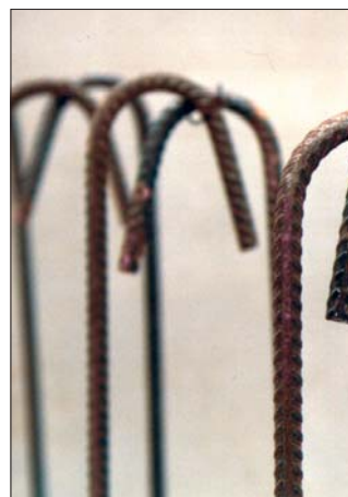
Bild 3: Steckisenendhaken zur Wandmitte ausrichten
