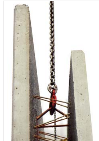
Bild 4 und 5: Element an den vorgesehenen Anschlagmitteln anhängen
