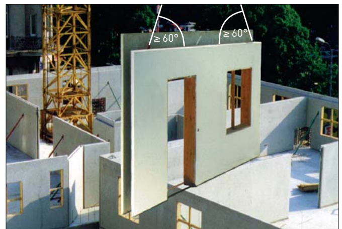
Bild 8: Das Element am Kran
