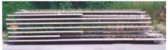
Bild 7: Lagerung der Deckenelemente
