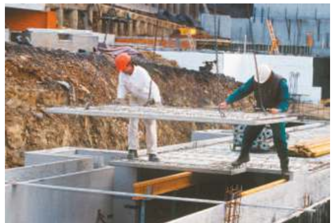
Bild 15: Verlegen der Deckenelemente
