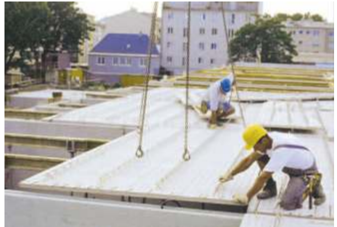
Bild 8: Verlegen der Deckenelemente
