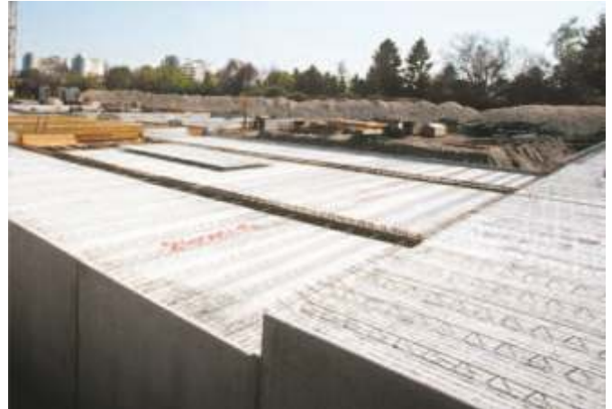
Bild 16: Fertig verlegte Elementdecke
