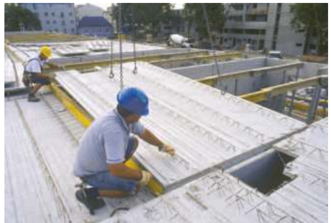
Bild 9: Mindestauflagertiefe: empfohlen 5 cm, sonst Randunterstellung
