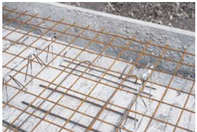
Bild 10: Obere Bewehrung und Fugenstoßbewehrung
