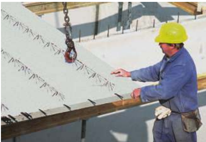
Bild 12: Verlegen der Deckenelemente
