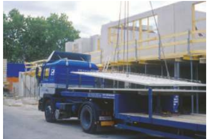
Bild 14: Abladen der Elemente
