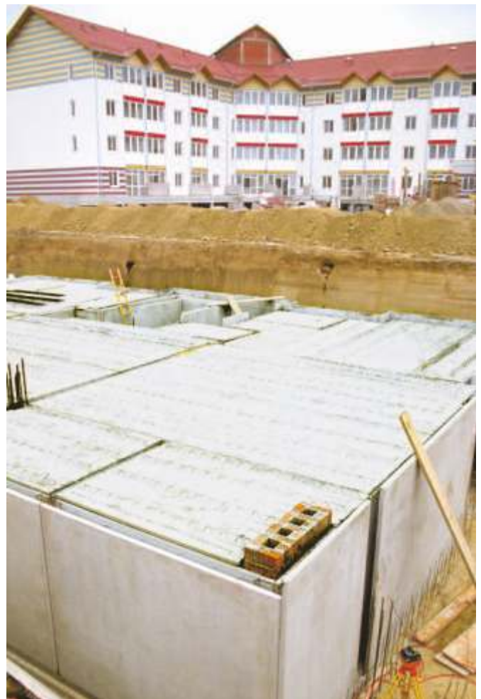
Bild 17: Elementdecke auf Großkeller
