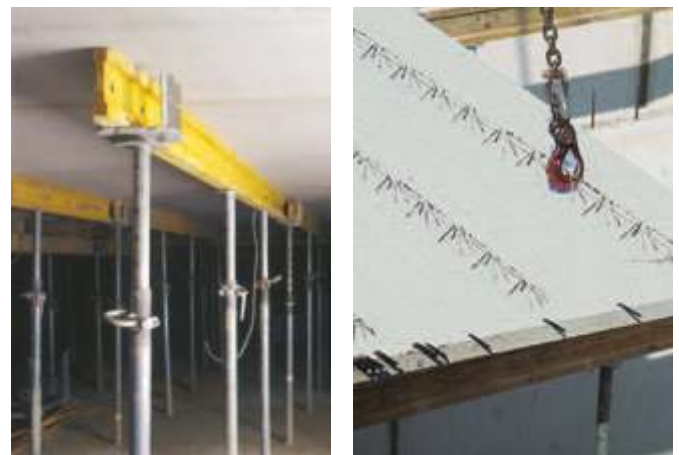
Bild 3 und 4: Montageunterstellung
