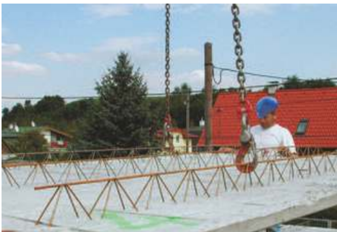
Bild 13: Einheben eines Deckenelementes
