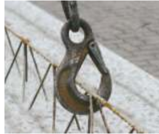
Bild 5: Kranhaken in Knotenpunkten der Gitterträger einhängen
