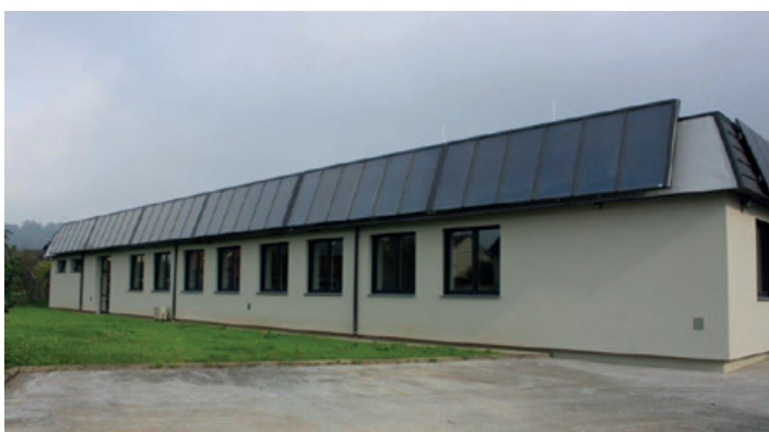
Büro- und Schulungszentrum der Leistungsgruppe von Installateuren HandelsmbH (LSI) 1)
