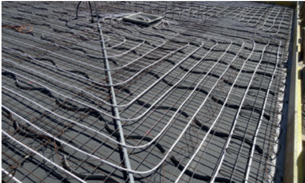
Abbildung 4: Lage der Rohre vor den Betonierarbeiten 1)
