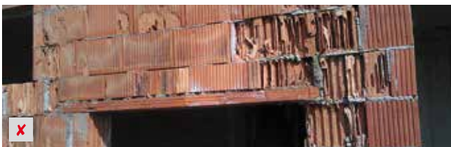
Schadhaftes Ziegelmauerwerk
